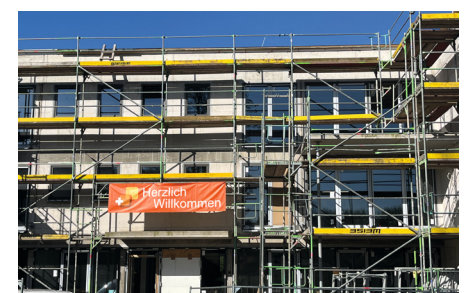
Aktueller Stand der Bauarbeiten Haus Heinrich. Foto: SBH
